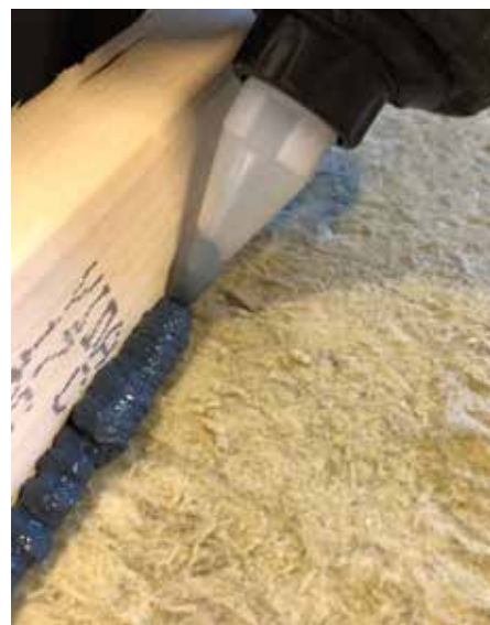
AEROSANA VISCONN Kanten fuges så der dannes hulkel.
