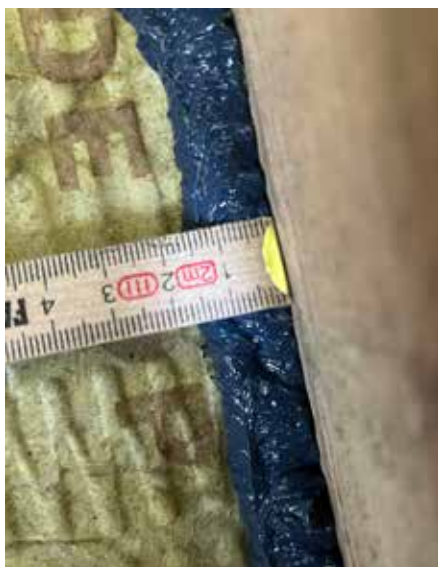
AEROSANA VISCONN fugetykkelse Ø 15 mm.
