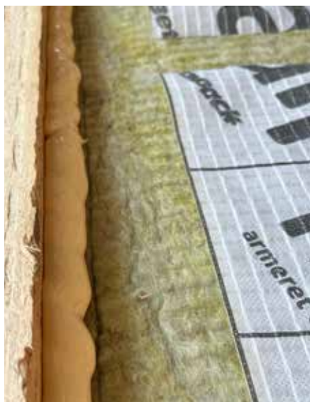
alpha Folieklæber fugetykkelse Ø 20 mm.
